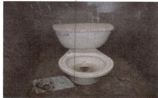
Foto 4: Sustitución de inodoros y sus accesorios
