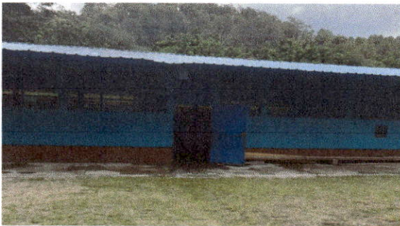
Foto 3: Pintura en muros exteriores e interiores
